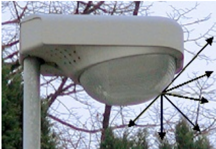
Figura 1. a) Apparecchio stradale diffondente: grande emissione a piccoli angoli; b) Superficie diffondente: piccola emissione a piccoli angoli.
